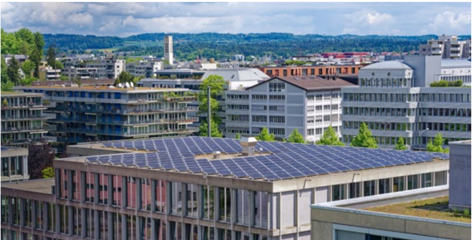
Voilà ce qu'il faut faire : les capteurs solaires doivent être placés sur les toits et non dans la nature. Source : iStock
