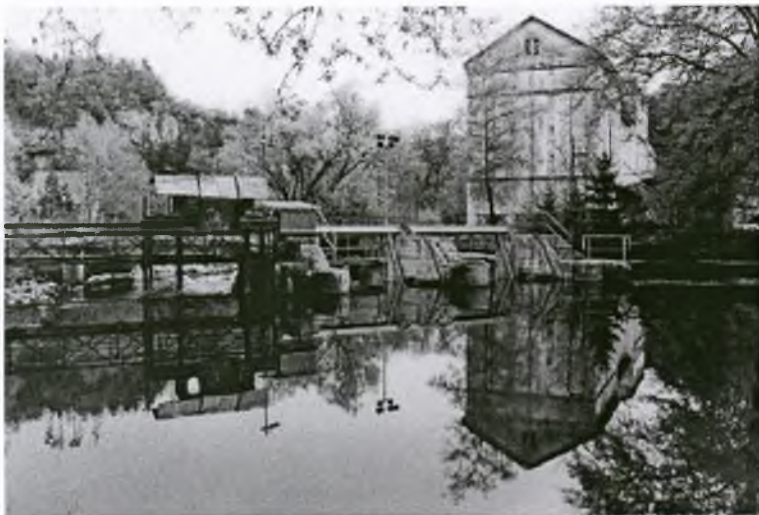
Klein-Wasserkraftwerk an der Birs bei Laufen BL (ADEV Wasserkraftwerk AG)
