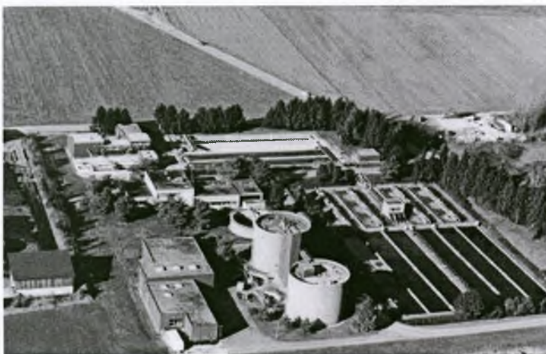
Klärgas-Blockheizkraftwerk in Grenchen (Planungsfirma: Holinger AG, Bern)
