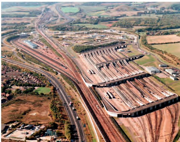
Le rampe di carico per la struttura provvisoria al San Gottardo sarebbero più grandi di quelle dell'Eurotunnel a Folkestone (foto).
