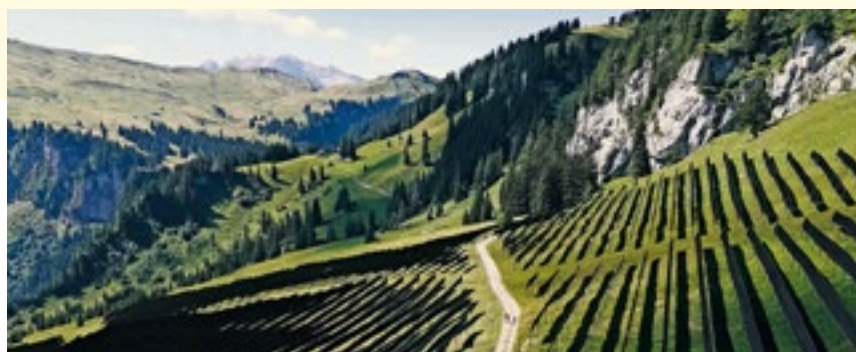
Vue sur une installation solaire alpine: la distance entre les rangées de panneaux est de 4 à 7 mètres. source: obwaldnerzeitung.ch, Visualisierung: zvg
