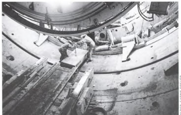
Einsetzen der Betonverschalung.
