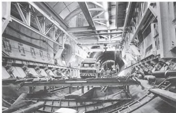
*Die Bohrmaschine wird 200 Meter lang sein.*
