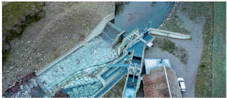
Le nouveau système de captage de la centrale de Schils peut être franchis par les poissons et les sédiments.
