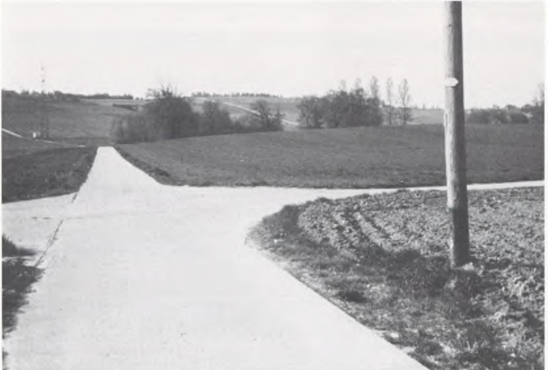
Infolge Melioration ausgebauter und mit einem Hartbelag versehener Güterweg, der für den Fußwanderer fast unbenütztbar geworden ist. – Glücklicherweise wurden einige Bäume und Sträucher am Bord stehen gelassen.
