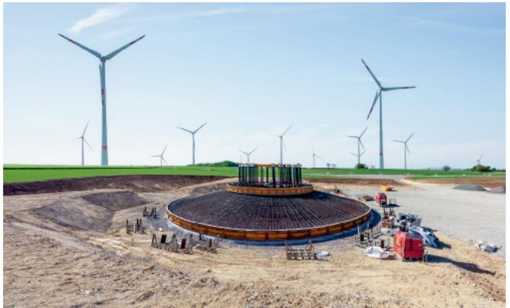
Zur Stabilisierung der Statik werden pro Windturbinen-Turm bis zu 10'000 Tonnen Beton als Fundament im Boden versenkt. Je nach Standort und Untergrund muss bis zu zwölf Meter tief gebohrt und verankert werden. Die Eingriffsfläche beträgt 4'000 Quadratmeter pro Anlage, dabei werden 500 Quadratmeter Landwirtschafts- oder Waldfläche ein für allemal vollversiegelt; an einen Rückbau ist realistischerweise kaum mehr zu denken.
