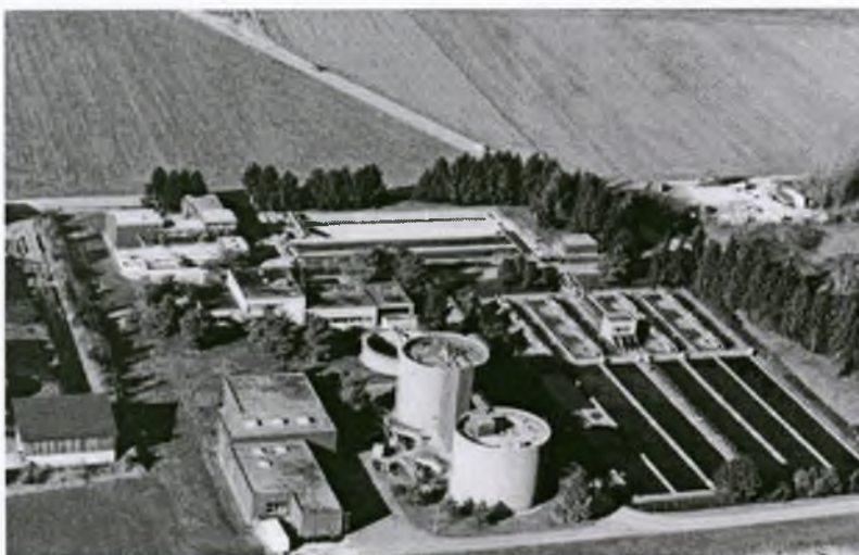
Klärgas-Blockheizkraftwerk in Grenchen (Planungsfirma: Holinger AG, Bern)
