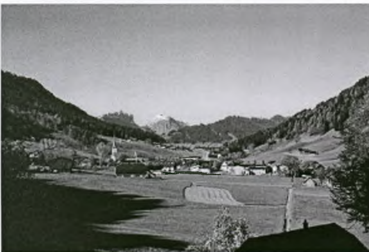
Holzschnitzel-Fernheizung in der Gemeinde Marbach (Josef Ottiger+Partner, Emmenbrücke)
