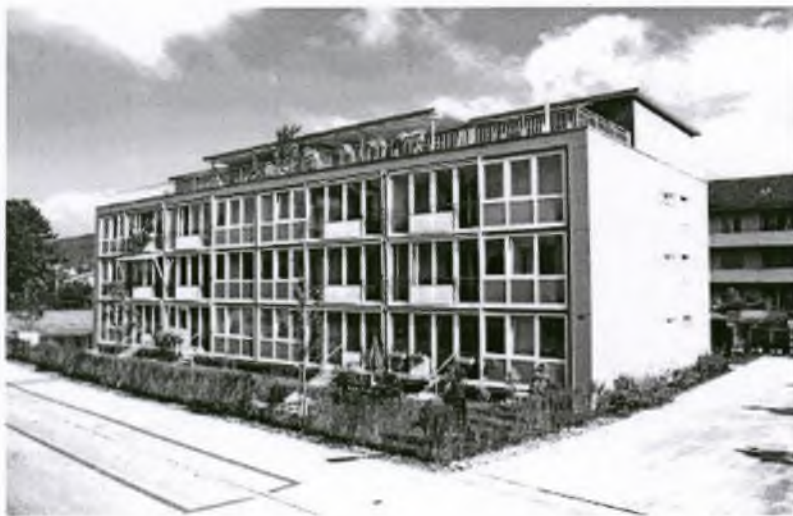
Mehrfamilienhaus in Wettingen (Architektur und Energieplanung: Batimo AG, Olten)
