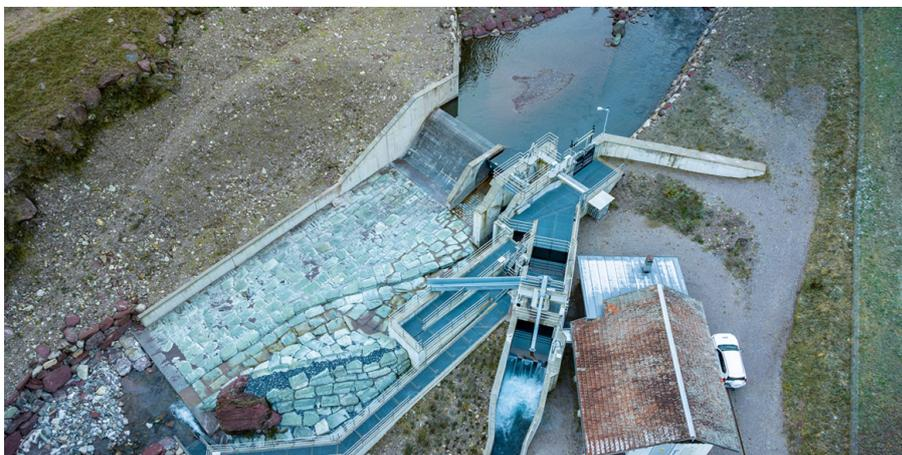
Kraftwerk Schils mit neuer Wasserfassung, für Fische und Sedimente passierbar.
