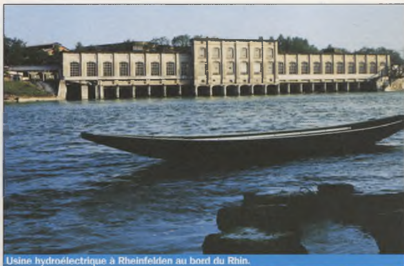
Usine hydroélectrique à Rheinfelden au bord du Rhin.
