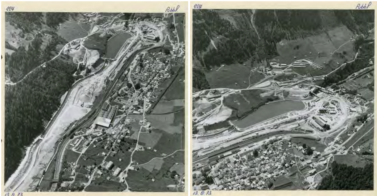
Bilder vom Bau der ersten Röhre in Airolo, der von 1970 bis 1980 dauerte: Der Landverbrauch ist enorm.
