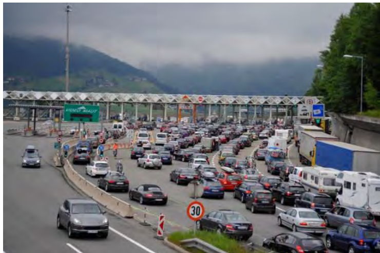
Die Mautstelle Schönberg am Brenner: 24 Spuren, fast 5 Fussballfelder gross, Lärm, Stress und Stau.
